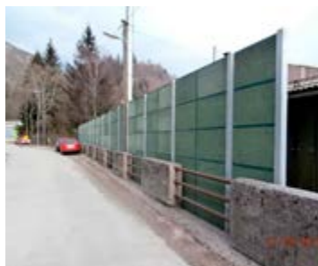
Protihrupna zaščita ob obratu Predelava debele pločevine
